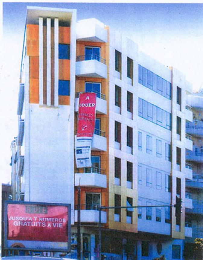
Le Tulipe Building, un immeuble de bureaux au milieu du quartier du Maârif ne passe pas inaperçu. Béton teinté dans la masse couleur sable, habillage en bois teinté à haute densité, menuiserie aluminium composée d'un mur-rideau de type VEC avec ouverture à l'italienne, vitrage en Bistadip teinté vert garantissant des performances phoniques intéressantes et enfin des lames brises soleil en Alucobond type aile d'avion double.
